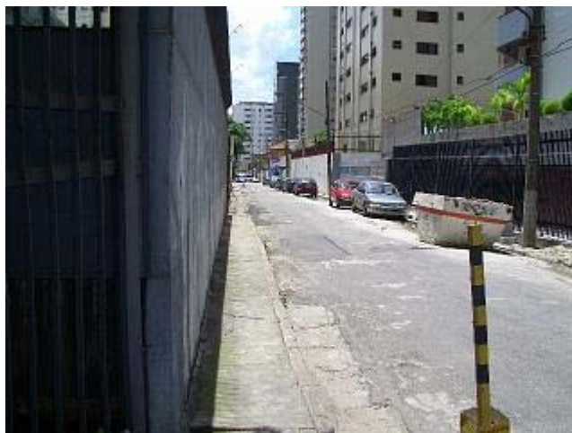
Fotografia 9 – Vista da Rua Caboquenas, entre Al. dos Anapurús e Al. dos Nhambiquaras, mostrando ondulações e reparos feitos no pavimento
