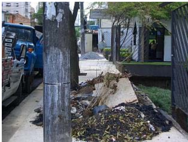
Fotografia 2 – Vista da calçada recomposta e do muro de fechamento demolido, na Av. dos Jamaris
