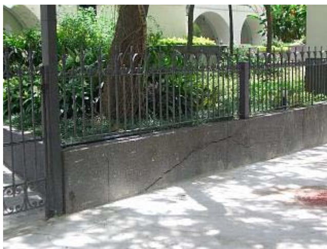
Fotografia 4 – Mureta com evidências de recalque, na Av. dos Jamaris
