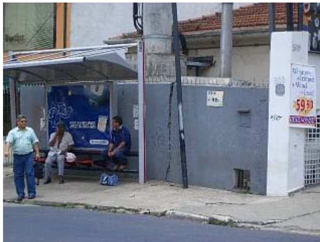
Fotografia 8 – Muros e calçadas mostrando acomodação, na Al. dos Nhambiquaras
