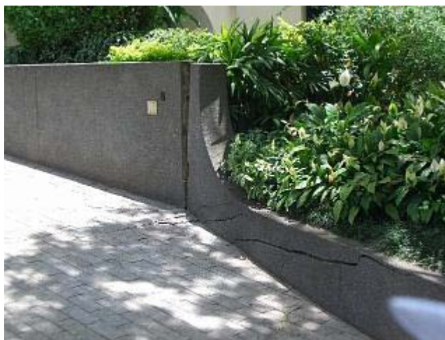
Fotografia 6 – Mureta destacada e com rachaduras em edifício da Av. dos Jamaris
