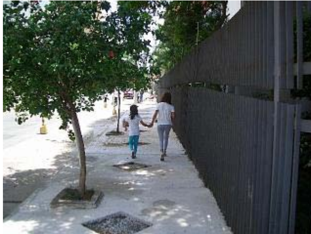
Fotografia 7 – Gradil na Al dos Anapurús apresentando ondulações
