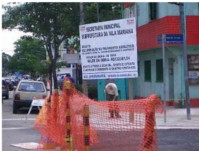
Fotografia 1 – Vista das obras de recuperação, na esquina da Av. dos Jamaris com Al. dos Nhambiquaras
