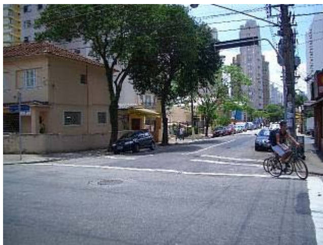
Fotografia 10 – Cruzamento da Al. dos Anapurús com a Av. dos Jamaris, mostrando ondulações e reparos feitos no pavimento
