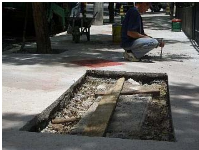
Fotografia 5 – Caixa de inspeção mostrando recalque, na Av. dos Jamaris
